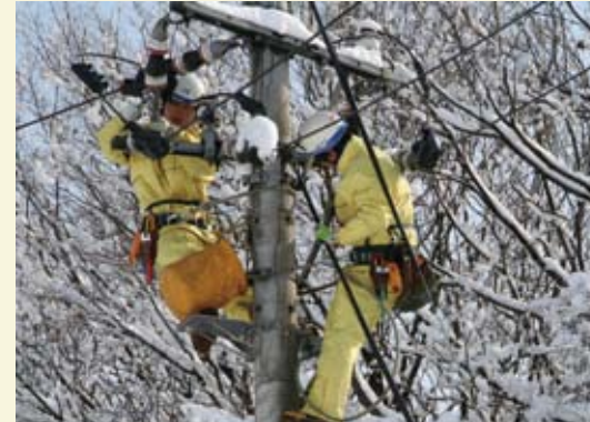
豪雪被害からの懸命の復旧作業（北陸電力）
