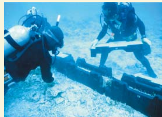
環境に配慮した海底ケーブルの敷設（沖縄電力）
