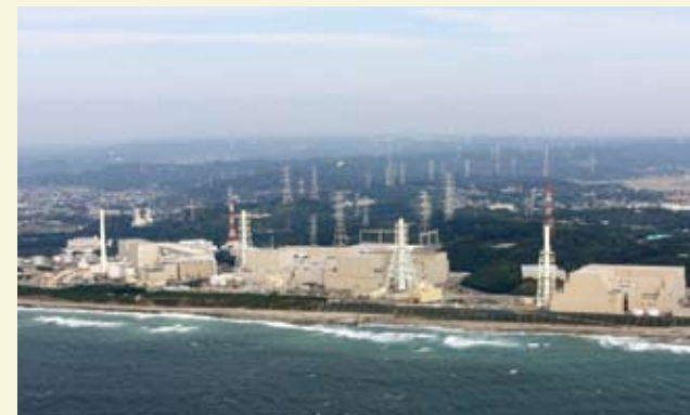
浜岡原子力発電所（中部電力）
