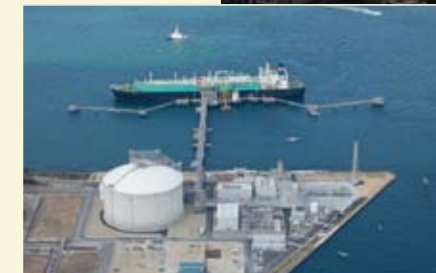
坂出 LNG 基地
