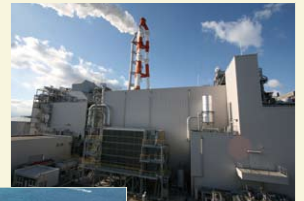
建設が進む坂出發電所 1 号機（四国電力）
