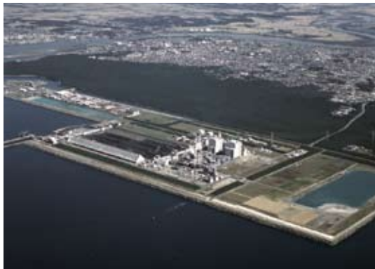
能代火力発電所（東北電力）
