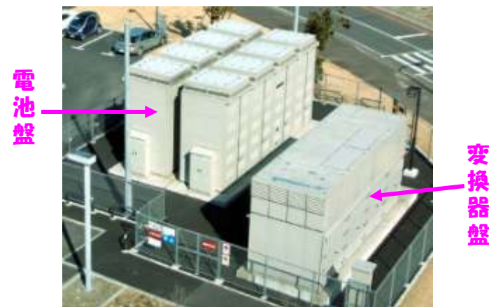
産総研つくばセンター設置のナトリウム硫黄電池システム(上左 2MW × 8時間; 下右は変換器盤)
