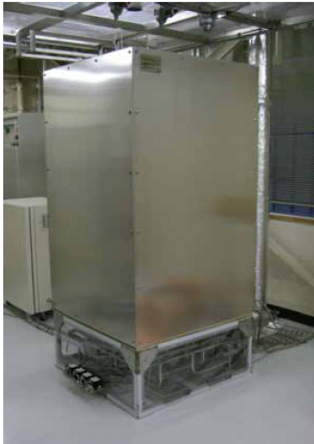
サイズ：縦999mm×横999mm×高さ2120mm 10kW級発電モジュール外観
