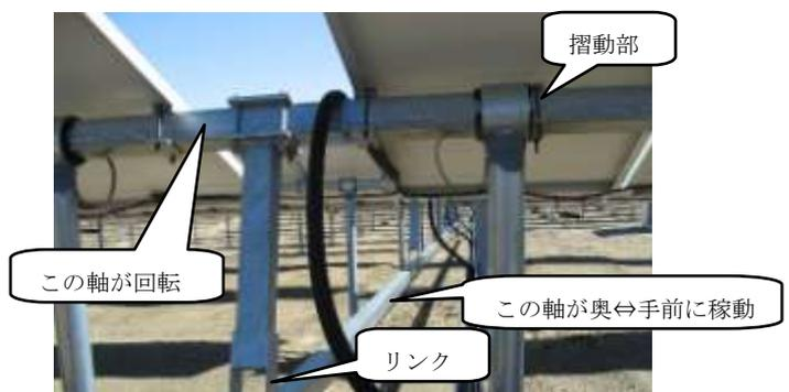
図 4.4 リンク機構及び軸
